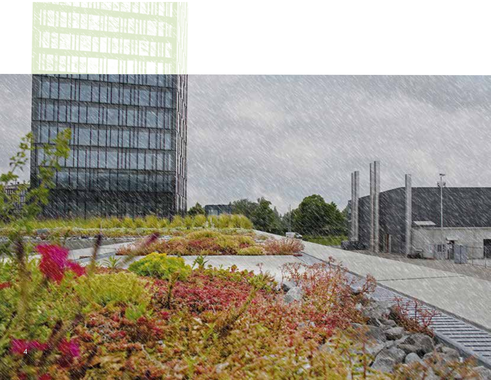
Retentionsflächen auf einem, als Innenhof angelegten, Tiefgaragendach in Ratingen.
