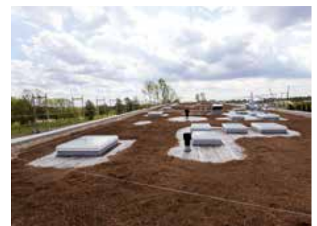
Die fertig eingebaute Systemerde "Steinrosenflur".
