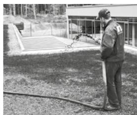
Die ZinCo Anspritzbegrünung ist rationell für große Flächen – sie bringt in einem Arbeitsgang Mulch- und Trägermaterial, Kleber, Nährstoffkomponenten sowie Saatgut auf. Die Vegetationstragschicht wird oberseits erosionssicher fixiert. Ebenso das Saatgut oder/und Sedum-Sprossen.
