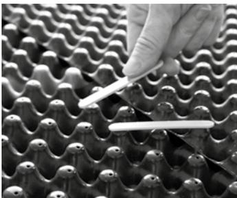
Zum sicheren Verbinden der auf Stoß verlegten Floradrain®-Platten; zum Eindrücken in die Diffusionsöffnungen; aus gelbem Kunststoff. Bedarf: ca. 2 Klammern/m<sup>2</sup>.
