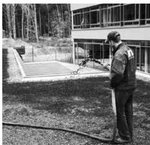
Die ZinCo Anspritzbegrünung ist rationell für große Flächen – sie bringt in einem Arbeitsgang Mulch- und Trägermaterial, Kleber, Nährstoffkomponenten sowie Saatgut auf. Die Vegetationstragschicht wird oberseits erosionssicher fixiert. Ebenso das Saatgut oder/und Sedum-Sprossen.
