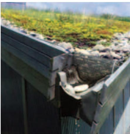
Abflussverzögerung einer extensiven Dachbegrünung.
