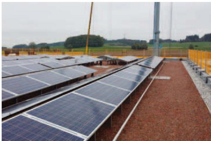
Das oben dargestellte System „SolarVert®“ ist für die klassische Südausrichtung konzipiert, mit einem maximalen Ertrag über die Mittagstunden. Vermehrt werden inzwischen aber auch Systeme mit Ost-West-Ausrichtung realisierbar, um einen gleichmäßigeren Ertrag über den Tagesverlauf zu erzielen und übermäßige Stromspitzen zu vermeiden. Siehe links das Beispiel Stadtwerke Weilheim. Mit der ZinCo-Solarbasis® SB 200 und Grundrahmen mit zum Beispiel 15° Neigung sind derartige Systeme ebenfalls machbar.
