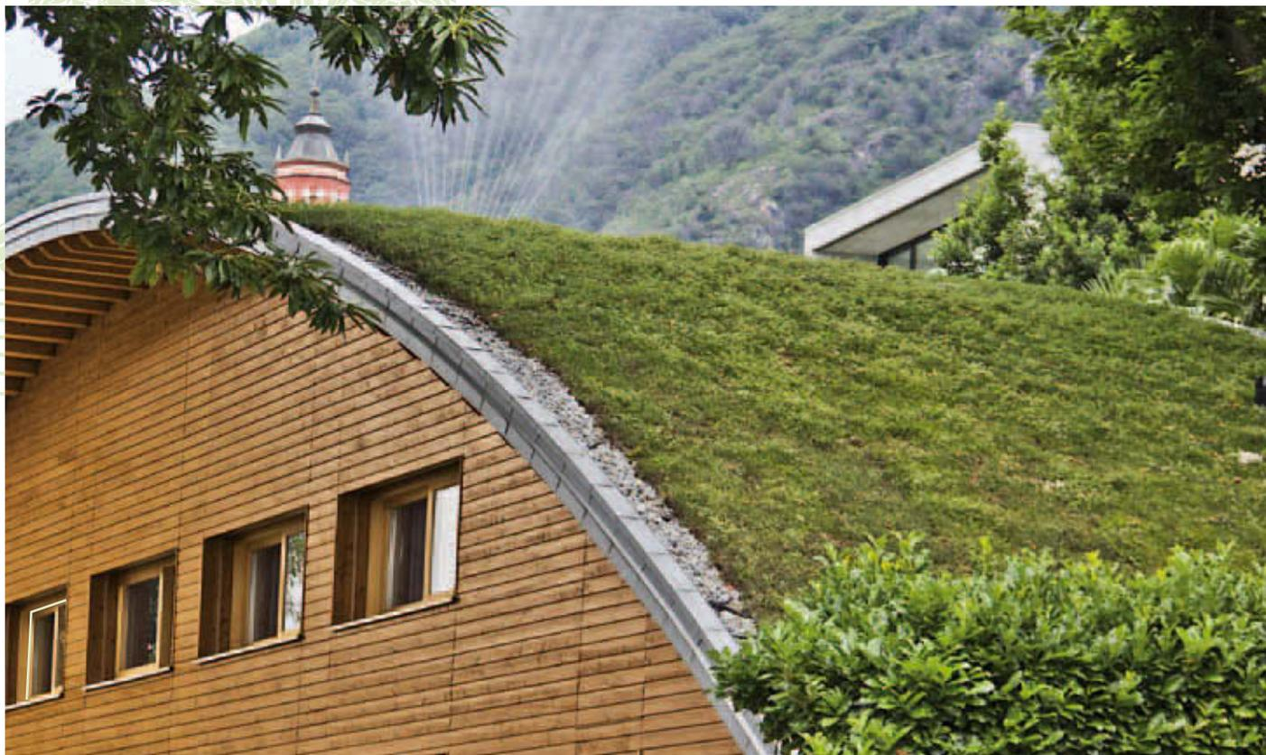
Mit dem hier vorgestellten Systemaufbau „Begrüntes Steildach“ auf Grundlage der ZinCo Georaster®-Elemente wird auch die Begrünung von Dachflächen mit über 25° Neigung möglich. Die ca. 54 × 54 cm großen und 10 cm hohen Georaster®-Elemente aus Recycling-Polyethylen (HD-PE) werden ohne Werkzeuge einfach ineinandergesteckt. Dies bewirkt sofort einen stabilen, flächigen Verbund. Eine mit den Raster-Elementen belegte Fläche ist sicher begehbar und mit Systemerde befüllbar.
