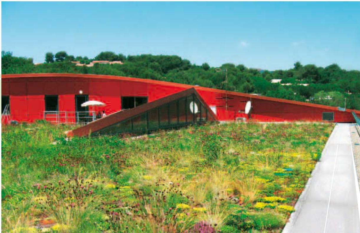
Mit der „Steinrosenflur“ lässt sich eine gestalterisch anspruchsvolle Extensivbegrünung mit individuellem Charakter realisieren. Die Substrathöhe im Systemaufbau liegt bei mind. 7 cm Systemerde „Steinrosenflur“. Die „Steinrosenflur“ kommt vor allem dort zum Einsatz, wo Arten bewusst eingesetzt werden sollen. Möglichst viele verschiedene Arten sorgen für eine lange Blütezeit.
