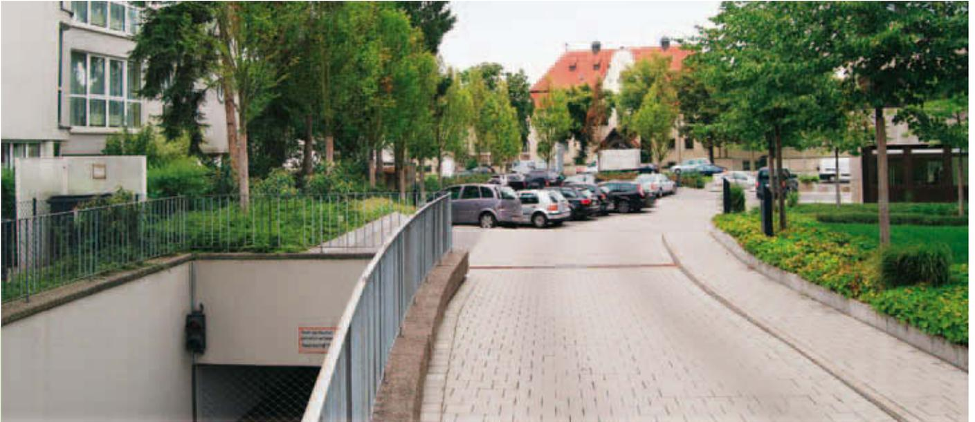
Fahrbeläge auf Dachflächen erfordern nicht nur einen tragfähigen Systemaufbau. Auch Kriterien wie die Tragfähigkeit der Dachkonstruktion oder horizontale Lasten, die durch Bremsen, Lenken und Beschleunigen entstehen, müssen berücksichtigt werden. Die Wahl der richtigen Steindicke und Verlegeart stellt sicher, dass die Pflasterung in ihrer Form erhalten bleibt.
