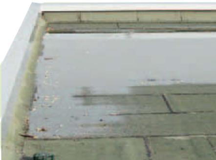
Auf 0°-Dächern, auf denen mangels Gefälle tiefere Pfützen zurückbleiben, muss der Standard-Systemaufbau abgewandelt werden. Durch den Einbau der 5 cm bzw. 7,5 cm hohen Floraset®-Dränage-Elemente wird der notwendige Abstand zum stehenden Wasser sichergestellt.
