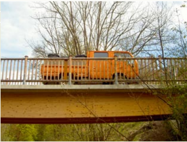
Ausführungsbeispiel Straßenverkehrsbrücke bei Wien (Spannweite: 17,60 m)
