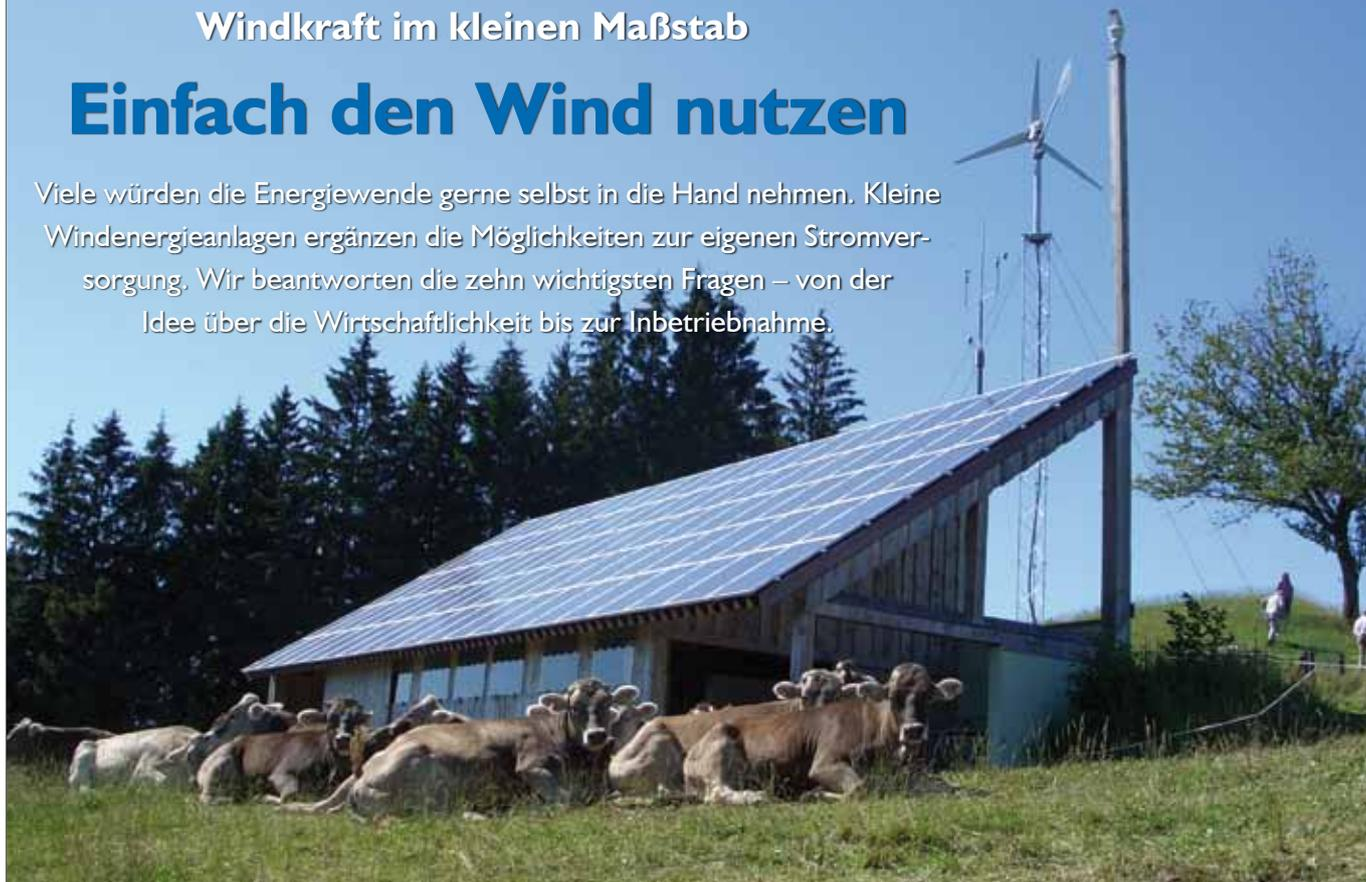
PV-Module und eine 5-kW-Heywind-Anlage gewähren die sichere Stromversorgung einer Wetterwarte im Allgäu
