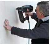
Bluclad Putzträgerplatten lassen sich mit handelsüblichen Werkzeugen schneiden und einfach auf Holz befestigen – auch bei schlechten Baustellenbedingungen. Die schimmelresistenten Bauplatten können bis zu zwölf Wochen ohne Putzauftrag frei bewittert werden. Kritische Schnittstellen zwischen Zimmermann und Maler werden so problemlos überbrückt.
