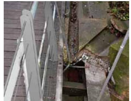
beschichtung im Farbton Eisenglimmer DB 702 festgelegt. Alle neuen Stahlbauteile wurden mit dem dunkleren Farbton Eisenglimmer DB 703 beschichtet, um diese auch optisch in den Hintergrund zu stellen.
