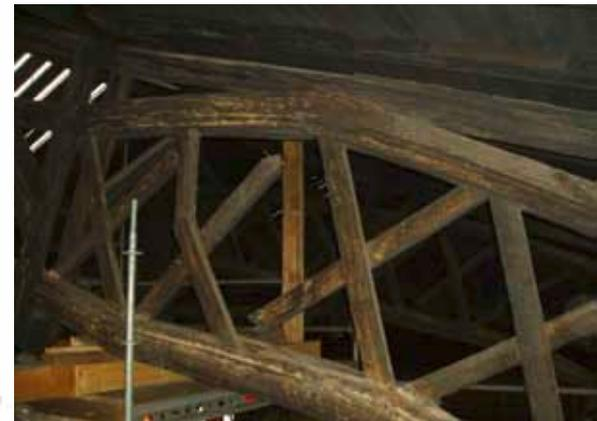
Ein weiteres Zugeständnis seitens der Denkmalpflege war die Verwendung von Schrauben. Zur Sanierung mussten der Ober- und Untergurt auseinandergebaut werden. Durch die Vernagelung war es kaum möglich, dies zerstörungsfrei zu bewerkstelligen.
