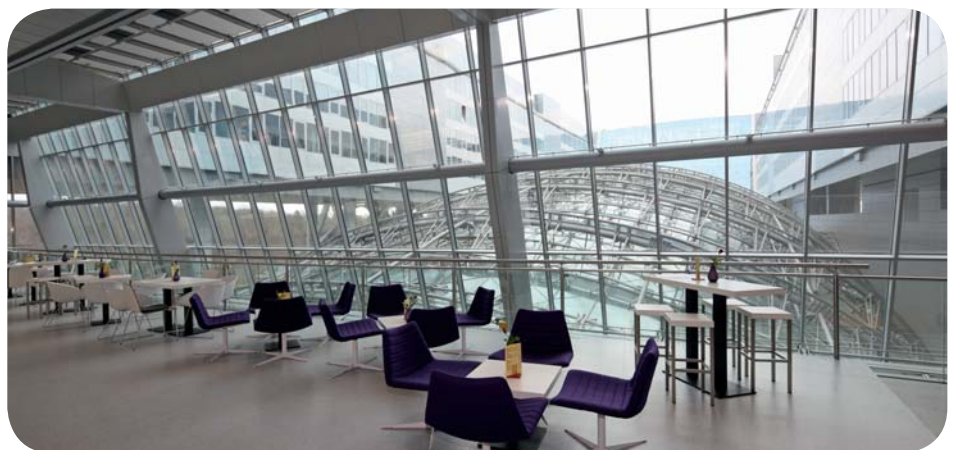
Treppenhäuser, Anbauten, Atrien oder Dachverglasungen können mit der Aluminium-Brandschutzfassade WICTEC FP in den Feuerwiderstandsklassen F(EI) 30 und G(E/EW) 30 realisiert werden.
