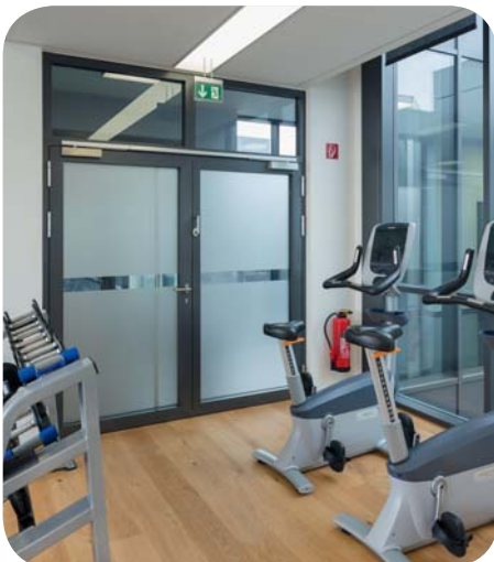
T 30-2 Türsystem als Fluchtwegzugang aus dem Fitness-Bereich. Die Pilkington Pyrostop®-Verglasungen der Türflügel wurden hier mit Sichtschutzfolien ausgestattet.
