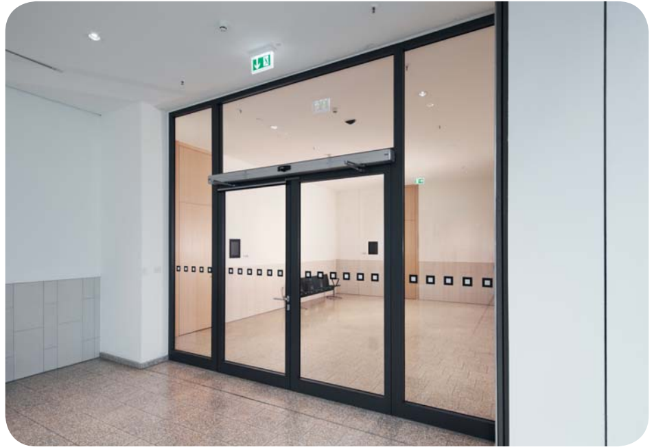
Sonderfall Gerichtsgebäude: Brandschutz kombiniert mit Sicherheitsanforderungen aufgrund potenziell hohem Personenaufkommen, optischem Aufbauschutz und Türautomatisierung.
