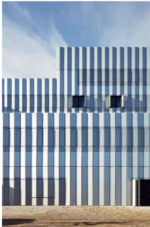
Thünen Institut, Neubau eines Labor- und Bü- rogebäudes mit Fischtechnikum, Bremerhaven 2017
