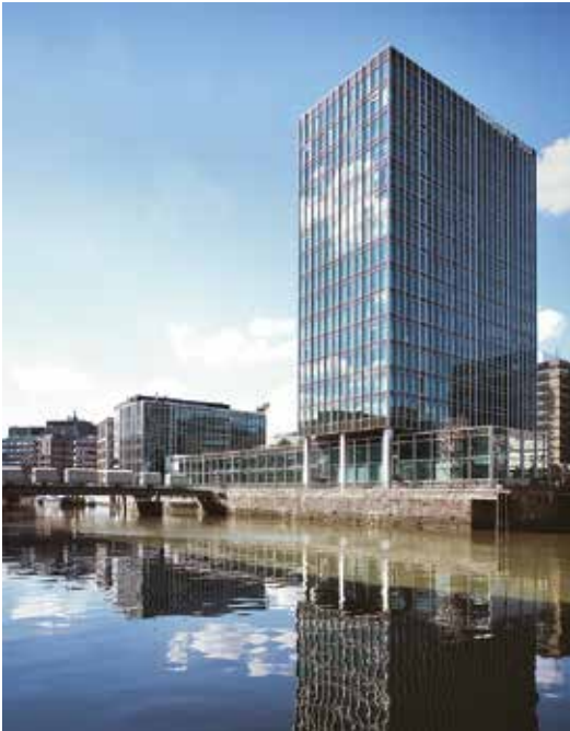
Sanierung und Erweiterung Hamburg Süd Headquarters, Hamburg 2016
