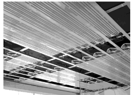
Abb.5 abgehängtes Deckenheiz-/kühlsystem
