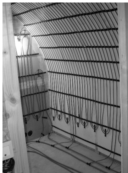
Abb.3 Wandheizsystem für Nassverlegung
